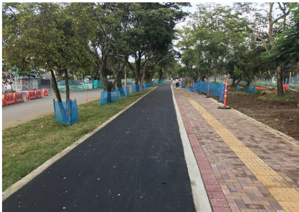
Figura 4: Ciclorruta Autopista Simón Bolívar - 1994 - Repavimentación 2022
