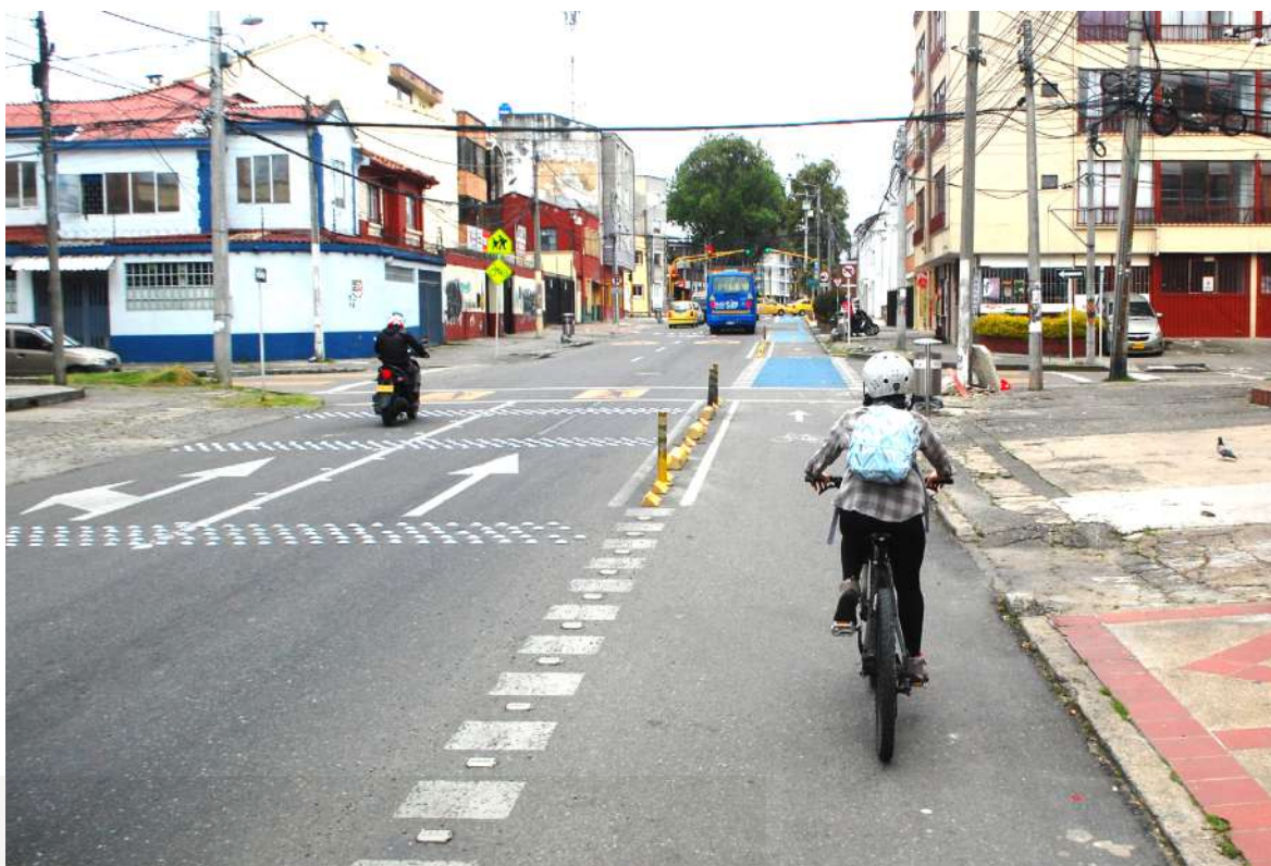
Ciclo-infraestructura a nivel de calzada en la Carrera 19, Bogotá. Foto: Thomas van Laake
