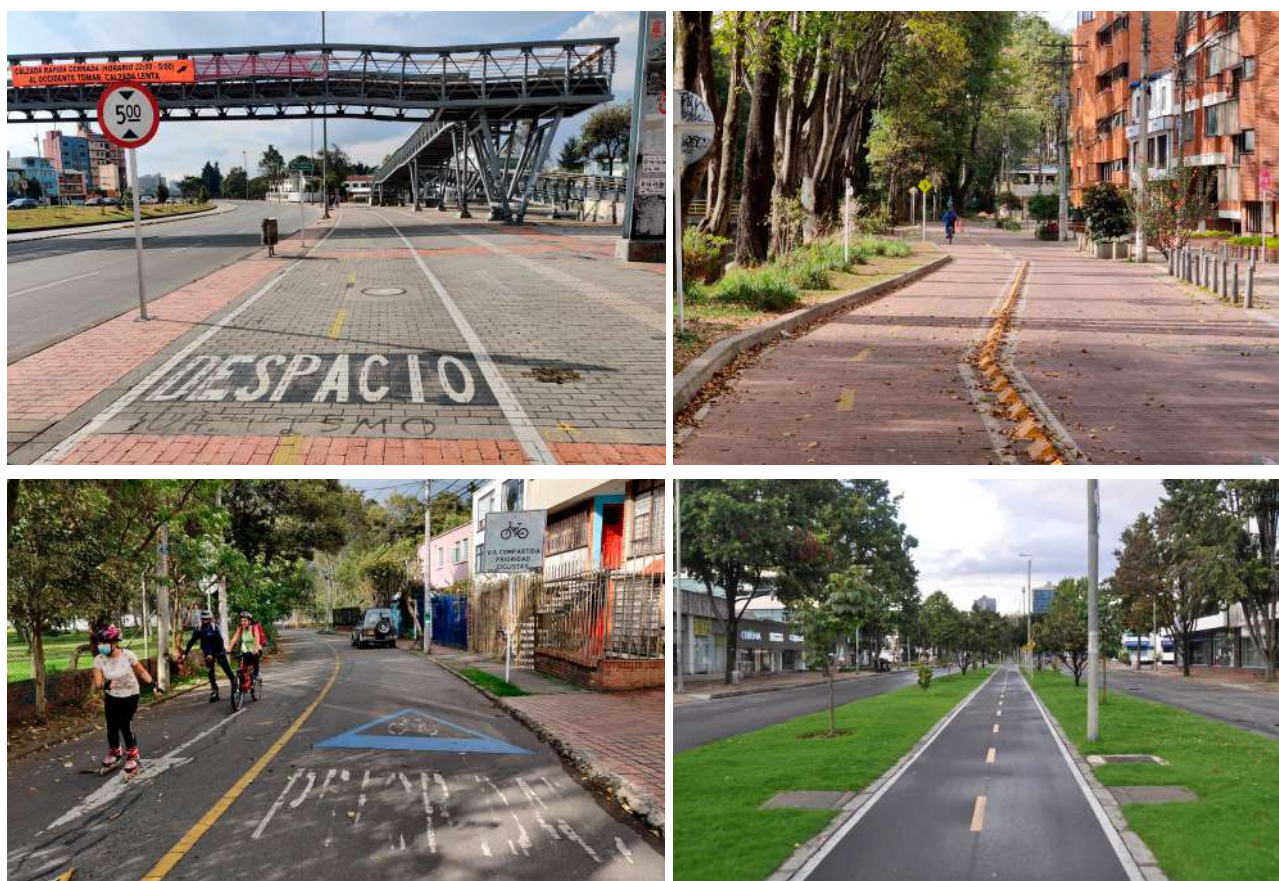
Ejemplos de tipologías de ciclo-infraestructura en Bogotá, categorizadas según la terminología definida en la Guía de ciclo-infraestructura para ciudades colombianas: (1) ciclobanda a nivel de andén (2) ciclorruta a nivel de calzada (bicicarril), (3) carril ciclo-preferente, (4) ciclorruta en separador Fotos: Daniel Pérez y Carlosfelipe Pardo
