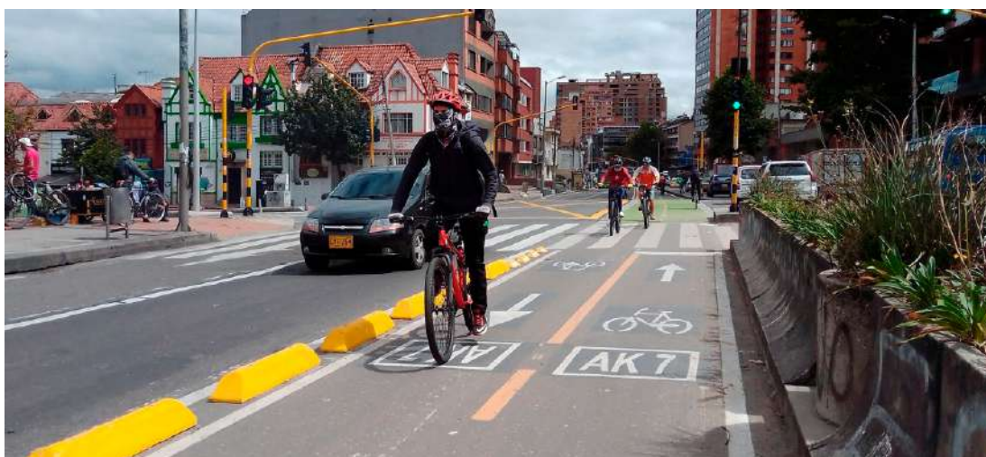
Figura 8. Segregación con elementos de concreto anclados al piso en la Carrera Séptima. Foto Carlosfelipe Pardo
