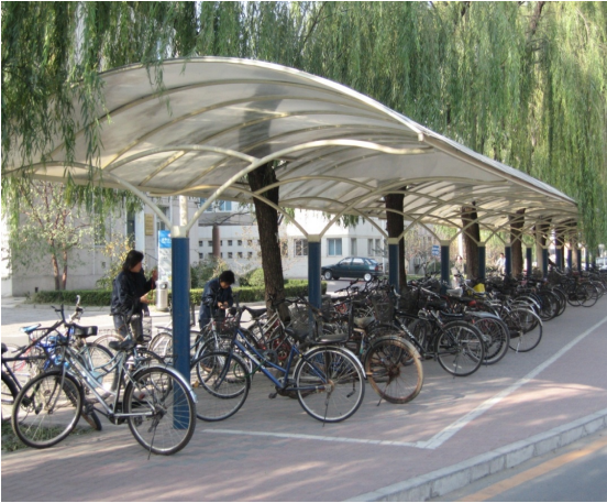
Figura 9. Estacionamiento con instalación de cobertura en Beijing
