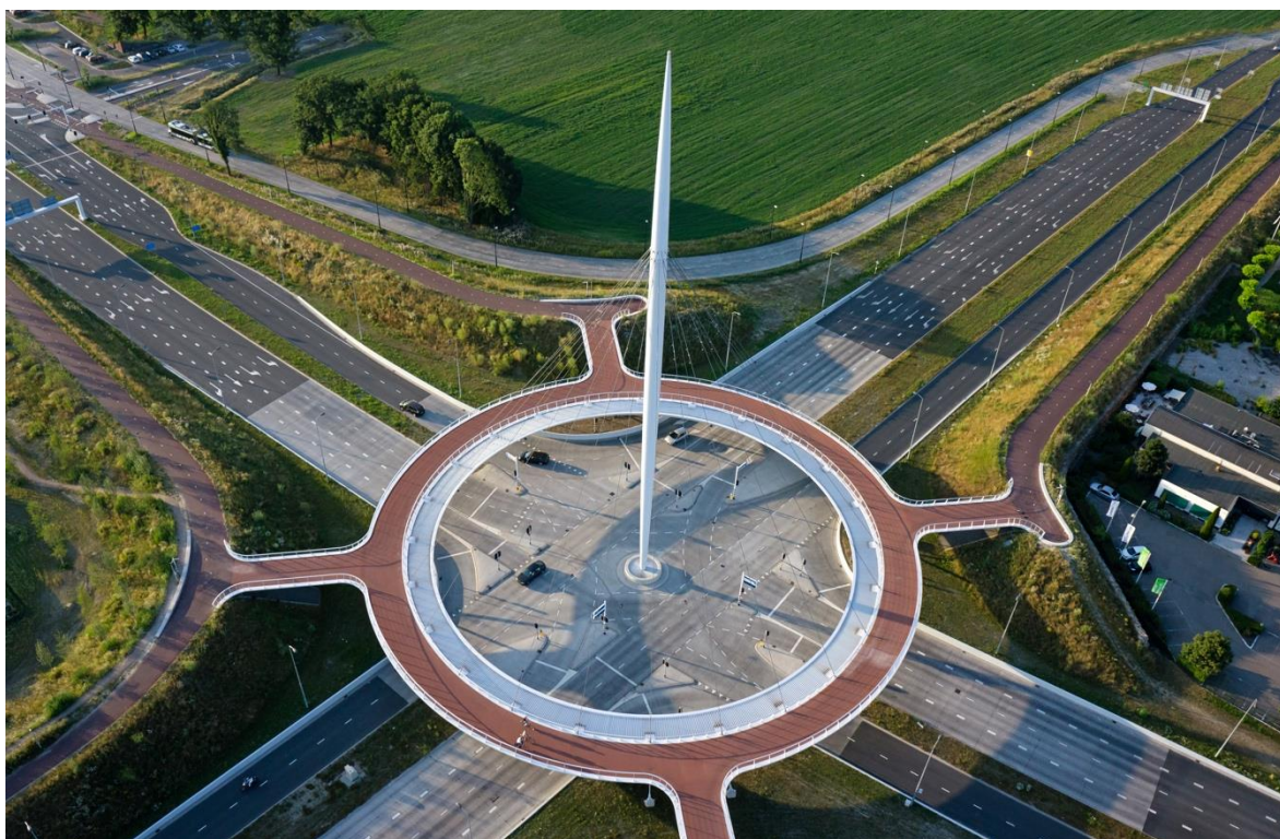
Figura 21. La 'Hovenring' en Eindhoven, la primera glorieta suspendida para bicicletas del mundo. Diseño y foto por ipv Delft.
