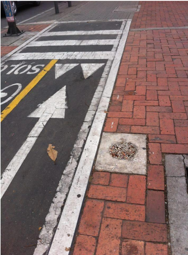
Figura 27. Señalización aún existente en ciclobanda
