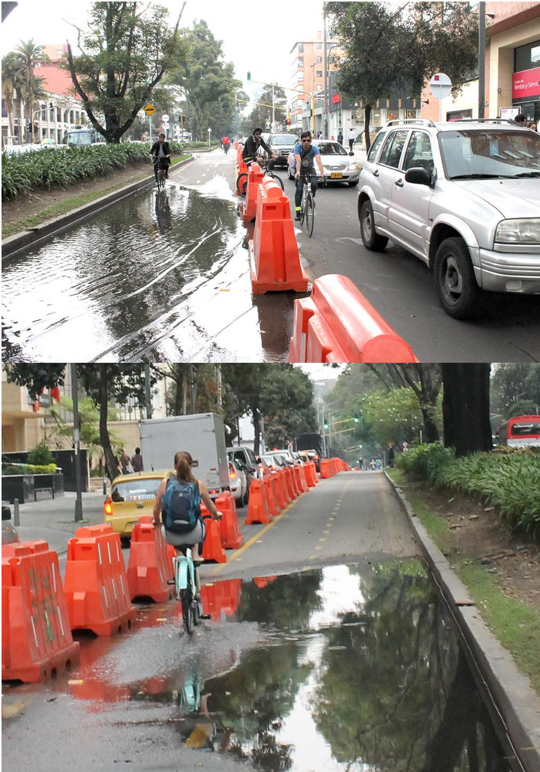
Figura 8. Maniobras peligrosas de ciclistas a causa de los charcos.
