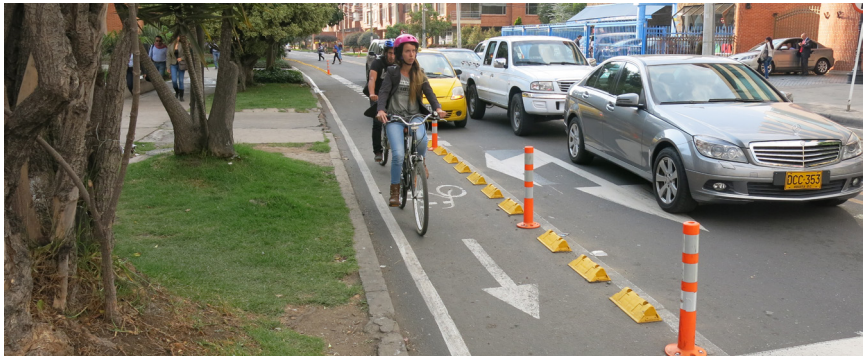
Foto 30. Elementos segregadores de ciclovías. Fuente: Patricia Calderón
