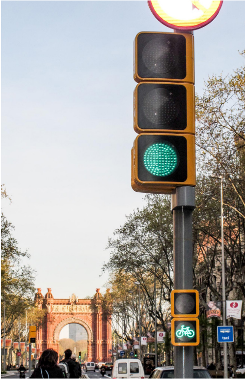
Foto 31. Semáforo para bicicletas adosado al semáforo vehicular (Barcelona). Fuente: Patricia Calderón
