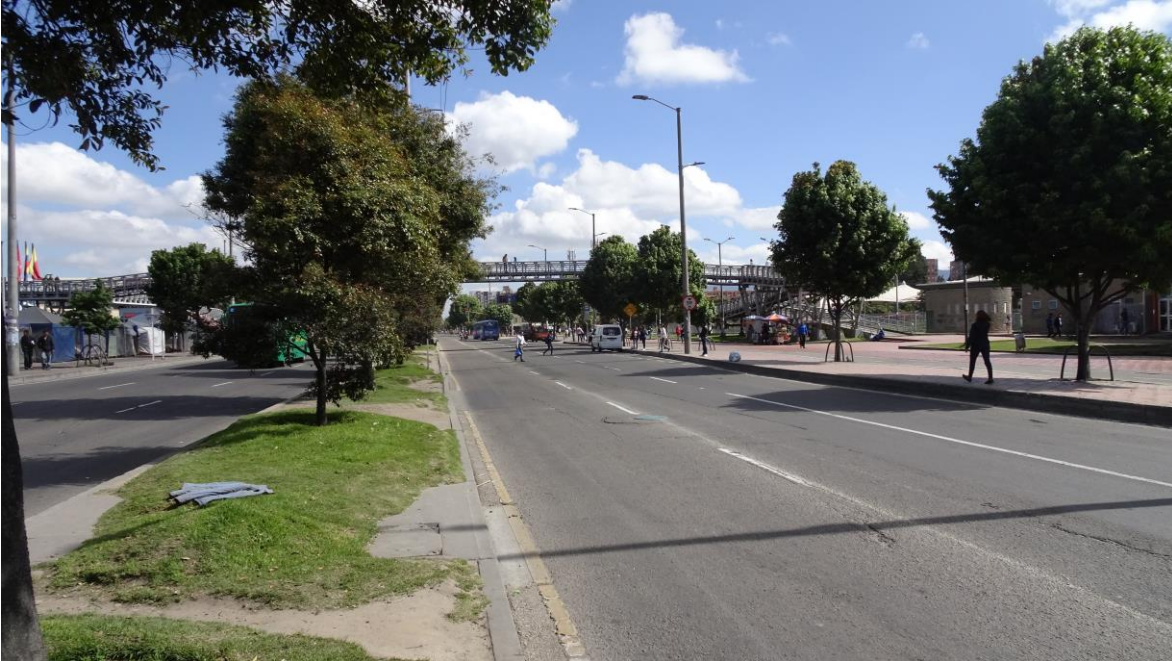
Figura 7. Tramo de la Carrera 104 y puente peatonal. Vista en dirección norte.
