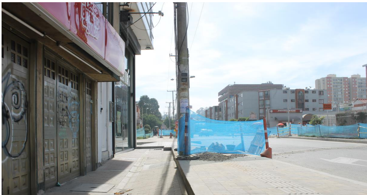
Figura 5. Desnivel en andén
